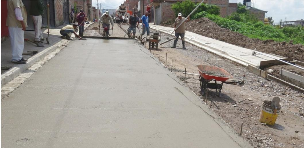
La administración 2015-2018 continúa con los trabajos de pavimentación en la calle Noche Buena de la colonia Buenos Aires, dando inicio a la construcción de losas de concreto hidráulico.
